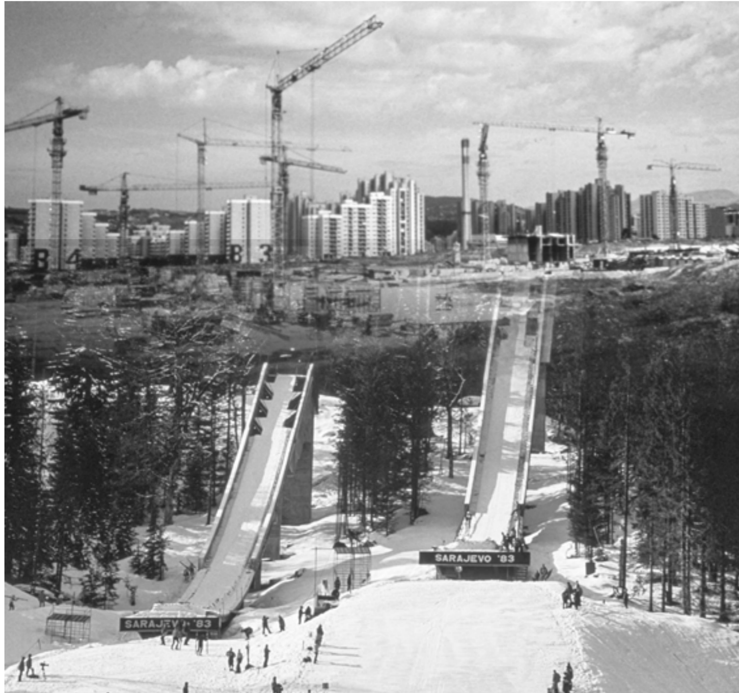
Izgradnja Olimpijskog sela Mojmiilo i Skijaške skakaonice na Igmanu
